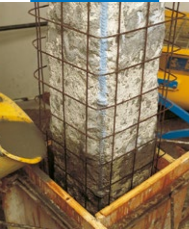
Verter en un encofrado
