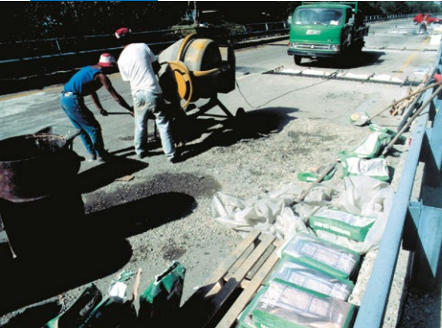
Reconstrucción de juntas en vías
