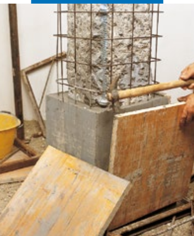
Retirar encofrados de madera
