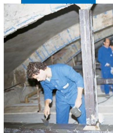
Vaciado de Mapegrout Hi-Flow E dentro de la formaleta metálica
