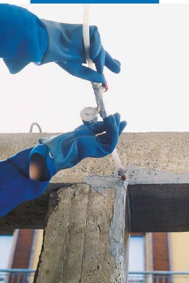
Viga placada con Adesilex PG1
