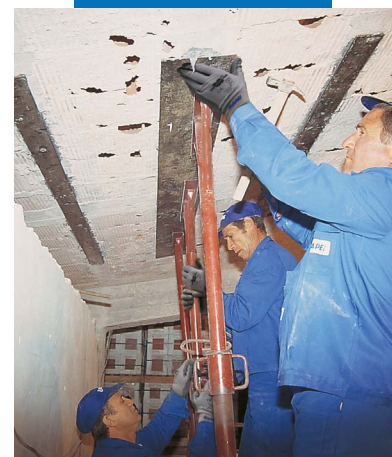
Puesta en obra de placa metálica para refuerzo estructural
