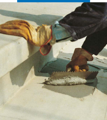
Aplicación mediante llana dentada de Adesilex PG1 para el encolado estructural de peldaños prefabricados
