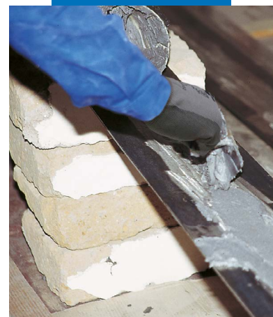
Aplicación de Adesilex PG1 sobre placa metálica
