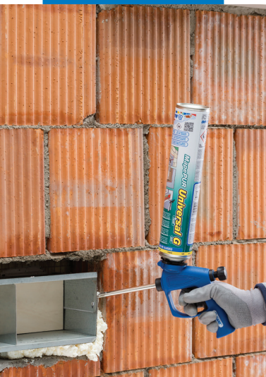
Relleno de conducto de ventilación
