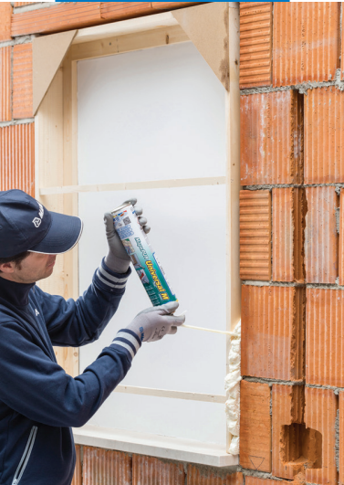
Relleno entre marco de ventana y pared
