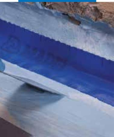
Aplicación de Mapeband en la unión pared-piso con Mapelastíc AquaDefense
