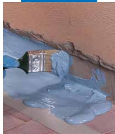
Aplicación con brocha de Mapelastic AquaDefense en la unión pared-piso, antes de la aplicación de Mapeband
