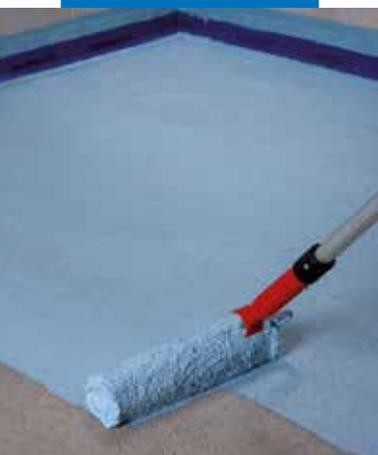
Aplicación de la primera capa de Mapelastíc AquaDefense sobre mortero o concreto
