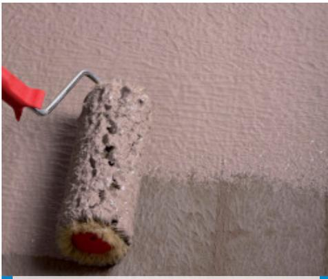
Impermeabilización de muro de cimentación a rodillo
