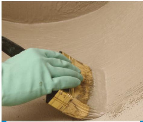
Impermeabilización de muro de cimentación a brocha
