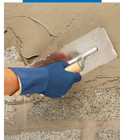
Aplicación de Planiseal 68 con llana
