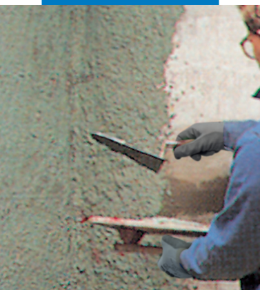
Capa de adherencia adhesiva aditivada con Planicrete Fluid CO
