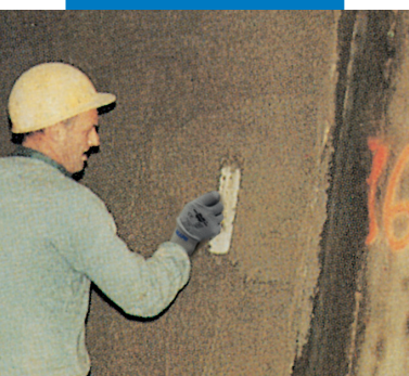
Revoque cementoso con Planicrete Fluid CO. Obra del túnel de la autopista Ville Marie en Montreal – Canadá
