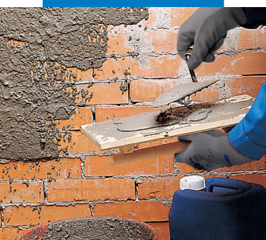
Capa de adherencia aditivada con Planicrete Fluid CO
