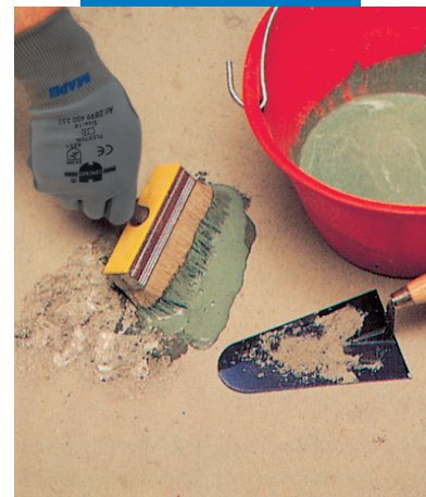
Reparación de un piso: aplicación de la lechada
