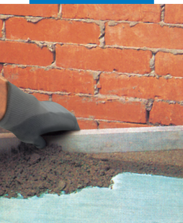
Aplicación de un recrecido cementoso adherente aditivado con Planicrete Fluid CO
