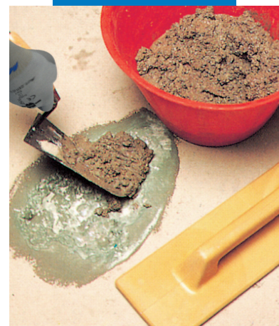
Reparación de un piso: aplicación del mortero
