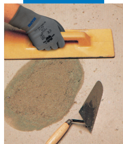
Reparación de un piso: final
