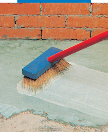
Aplicación de una lechada cementosa aditivada con Planicrete Fluid CO
