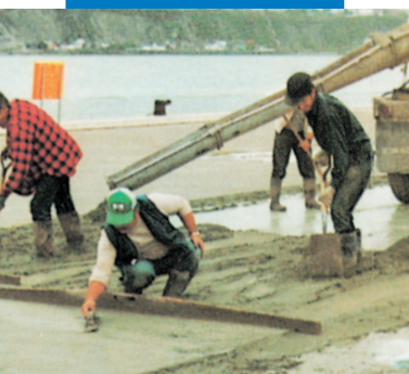
Mortero cementoso exterior aditivado con Planicrete Fluid CO. Obra Vieux Port, Québec, Canadá
